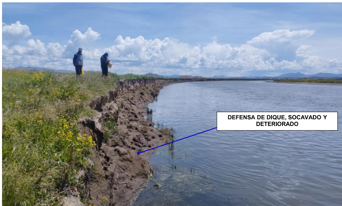
FIGURA N° 02: DIQUE NATURAL EN LA MARGEN DERECHA DEL RIO ILAVE EXPUESTO ANTE UN DESBORDAMIENTO EN EL TRAMO DE LA COMUNIDAD CAMPESINA CCALACHOCCO.
